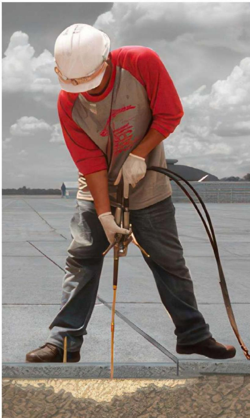
Stačí vyvrtat díry o průměru 10 mm do betonové desky a těmito otvory aplikujeme určité množství pěny, která během několika vteřin začne chemicky reagovat a zvětšovat svůj objem. Tímto způsobem je možné vyzvednout až několik desítek tun na 1 m<sup>2</sup>.
